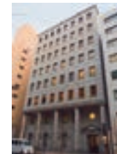
ユニデン本社ビル
